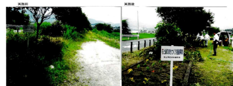
大戸川左岸（里1丁目）
